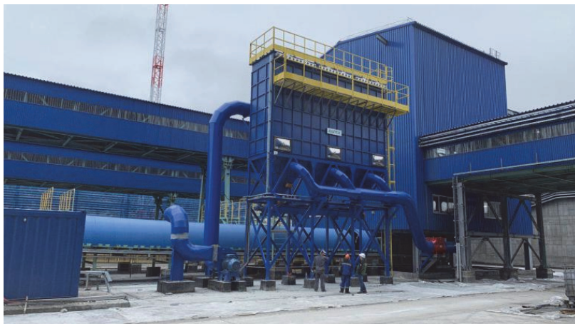
Рисунок 16 – Системы аспирации для пересыпок угольной пыли ленточных конвейеров в порту Восточном [17]
