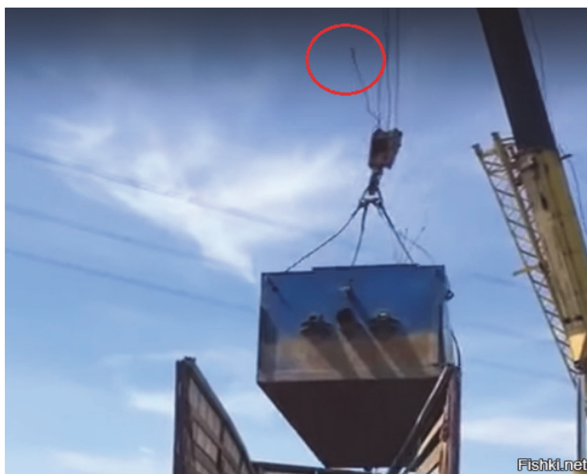
Обрыв стропы крана при перегрузке контейнера
