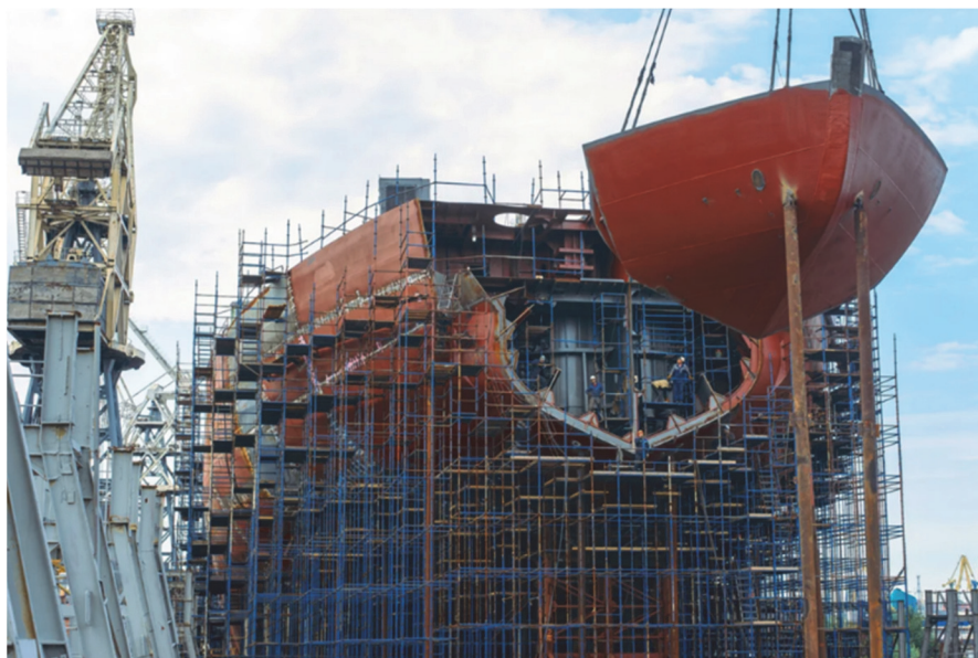
Рисунок 1 –Сборка корпуса атомохода «Якутия» из блоков-секций [1]
