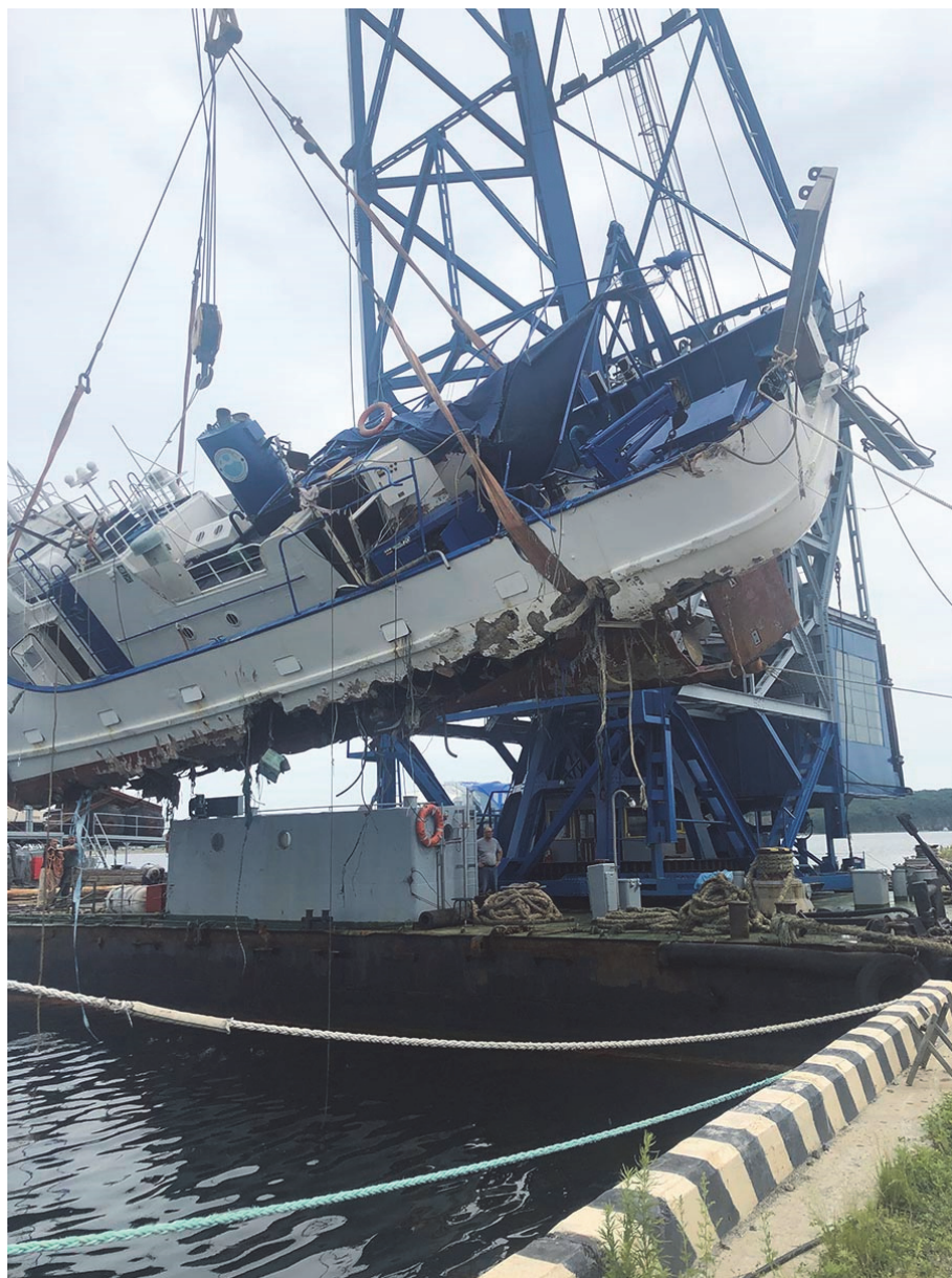
Рисунок 4 – Поднятый со дна моря НИС «Академик Владимир Касьянов» устанавливается на плавучий кран
